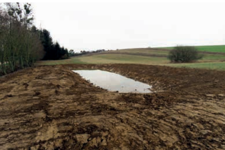
Anlage eines Kleingewässers bei Bedersdorf
