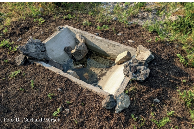
Betonbecken für die gefährdete Gelbbauchunke, Kalkwerk in Gersheim
