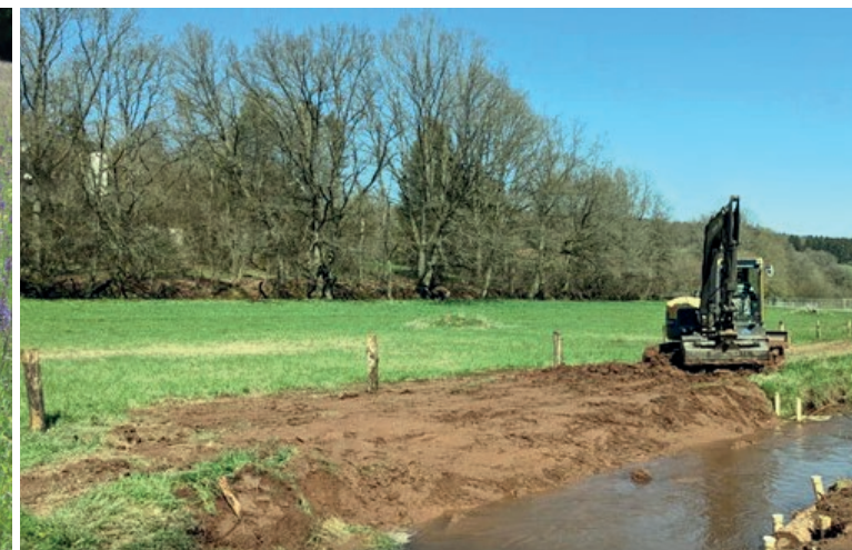
Gewässeraufweitung am Gerechbach
