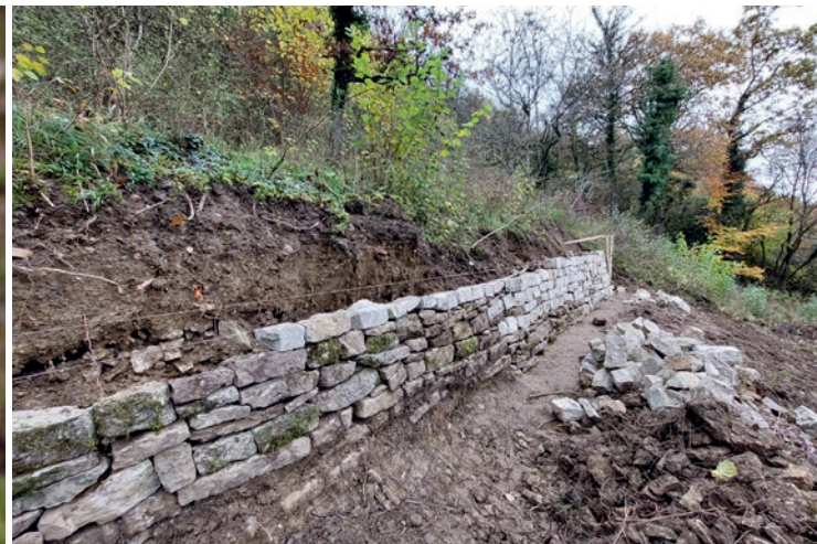
Sanierung einer alten Weinbergsmauer
