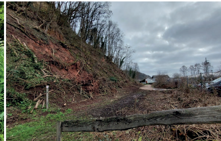
Verkehrssicherungsmaßnahmen am Bahnhof Beckingen
